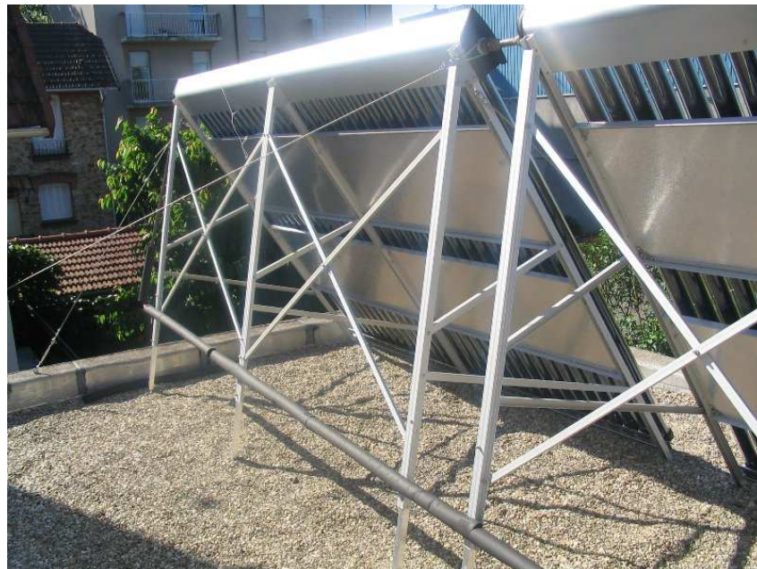
Fixation des câbles sur le collecteur et sur l'acrotère
