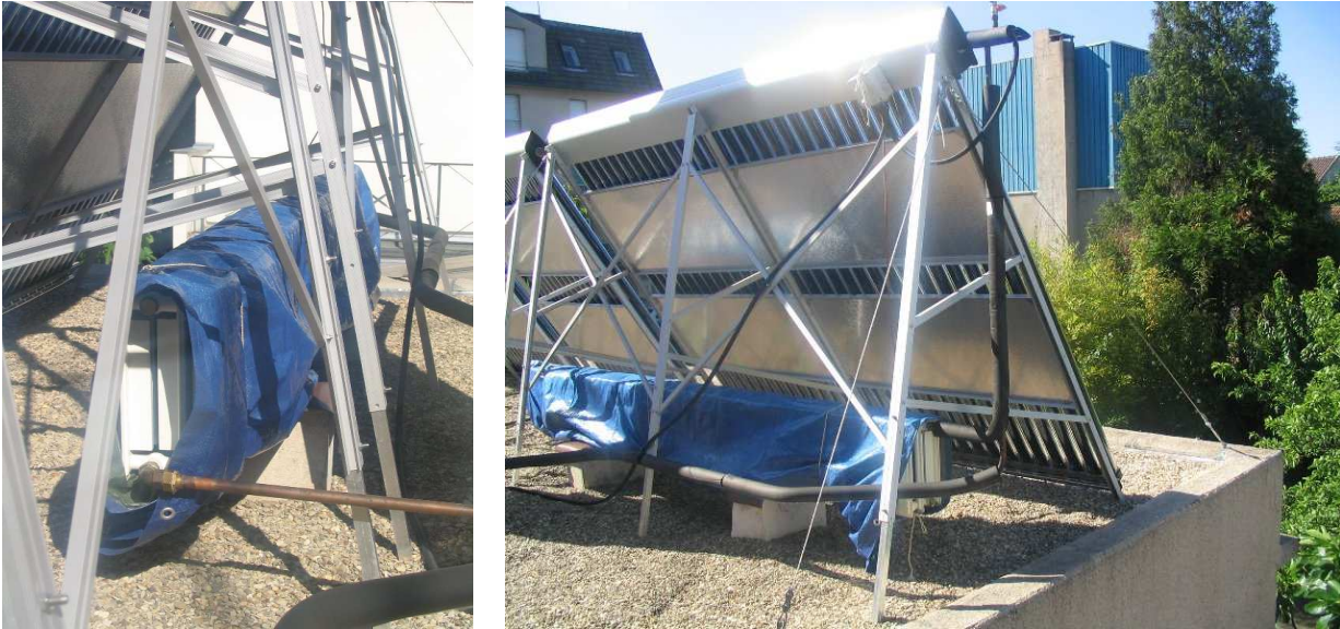
Le radiateur de surchauffe, bâché hors plein été pour limiter le risque de rouille
