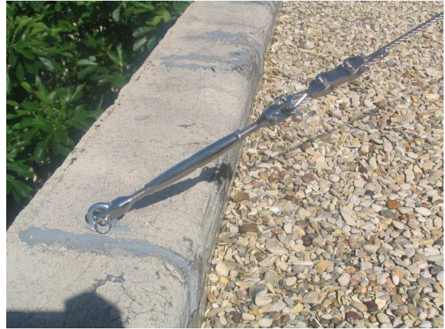
Fixation des câbles sur le collecteur et sur l'acrotère
