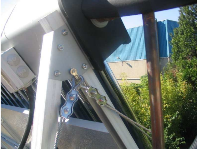
Fixation des câbles sur le collecteur et sur l'acrotère
